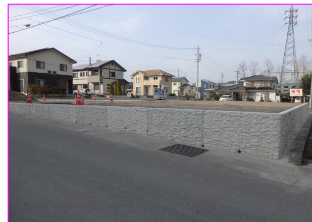
※南東側から撮影 (他区画側)
