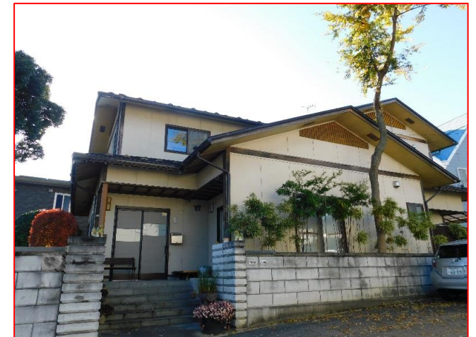
※北東側から撮影
